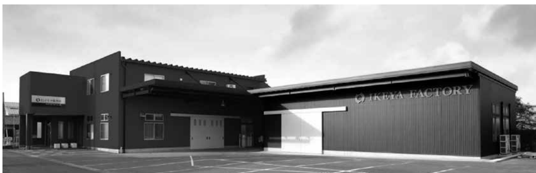
写真-1 本社工場の外観
